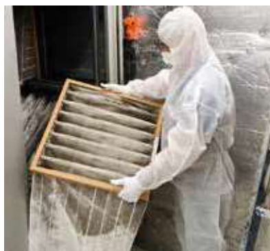
Wechsel Raumlufilter für reine Luft.
